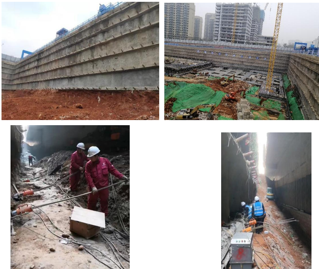
图 6 案例 1 施工现场照片
